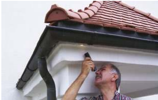
Abb. 20: Kontrolle des Quartiers im Dachkasten
